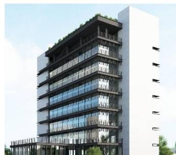
Project 75, Radnicka Str.
